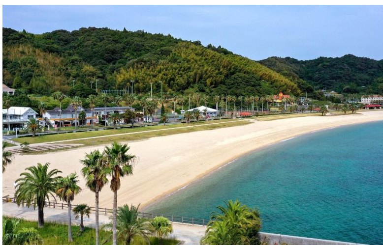
建物改修前の現地周辺。左端の白い建物が現地となります。
